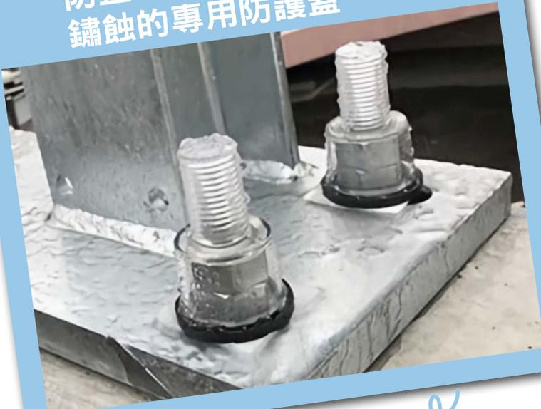
用遮罩蓋住螺栓與螺帽，這個單純的概念催生出日本Kyowa Rubber公司的「Mamoru-kun」防護蓋。只需沿著螺栓上多出來的螺紋，將防護蓋旋入就能完成安裝。防護蓋的IPX7級防水性能可預防螺栓生鏽，並延長基礎建設的壽命。
