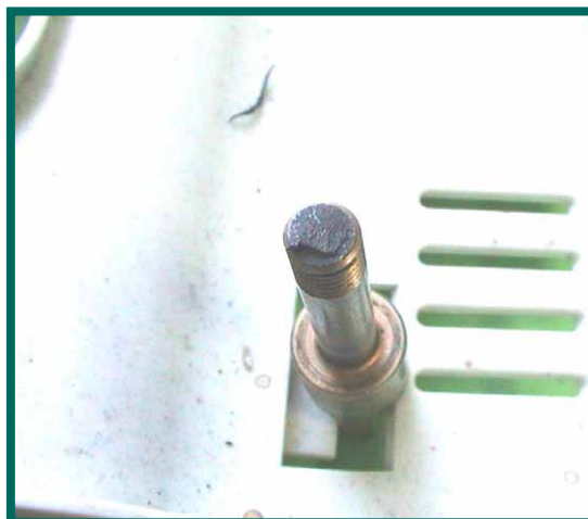
圖2 吊眼螺絲破斷面屬於快速破壞
