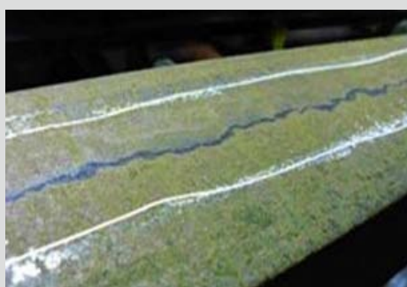
圖1. 鋼胚表面缺陷未研磨乾淨
