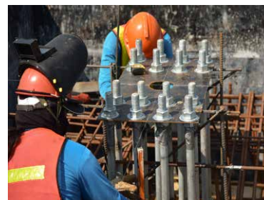
圖 8：安裝有頭錨栓
