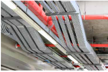
圖 1：作為吊架的螺紋桿
