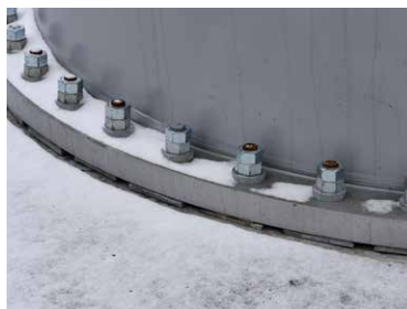
圖 7：風塔桅桿的錨固方式
